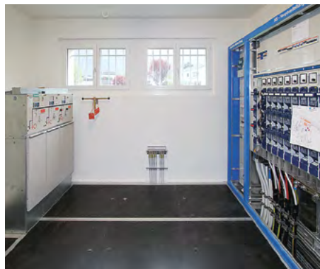
Die erneuerte Trafostation Sonnenweg in Näfels, Innen- und Aussenansicht
