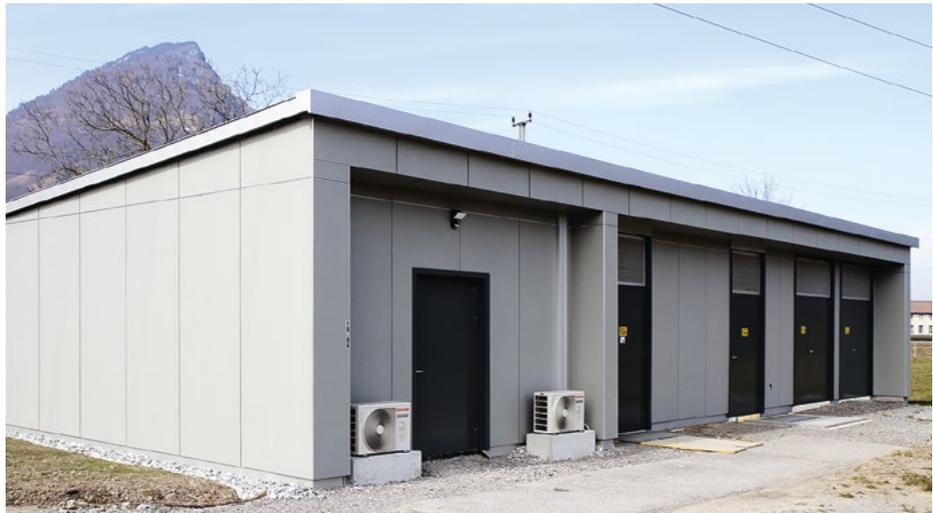
Bei der sanierten Mess- und Trafostation in der Frühatzung in Niederurnen mussten die technischen Einrichtungen wie auch das Gebäude saniert werden. Gespiesen wird diese Station auf der Hochspannungsseite (16 000 Volt) vom Unterwerk der Axpo in Niederurnen über Leitungen der Technischen Betriebe Glarus Süd (TBGS). Entsprechend gehören historisch auch einige Anlagenteile den TBGS, welche ab dieser Station das Arealnetz der Jenny Fabrics AG versorgen.
