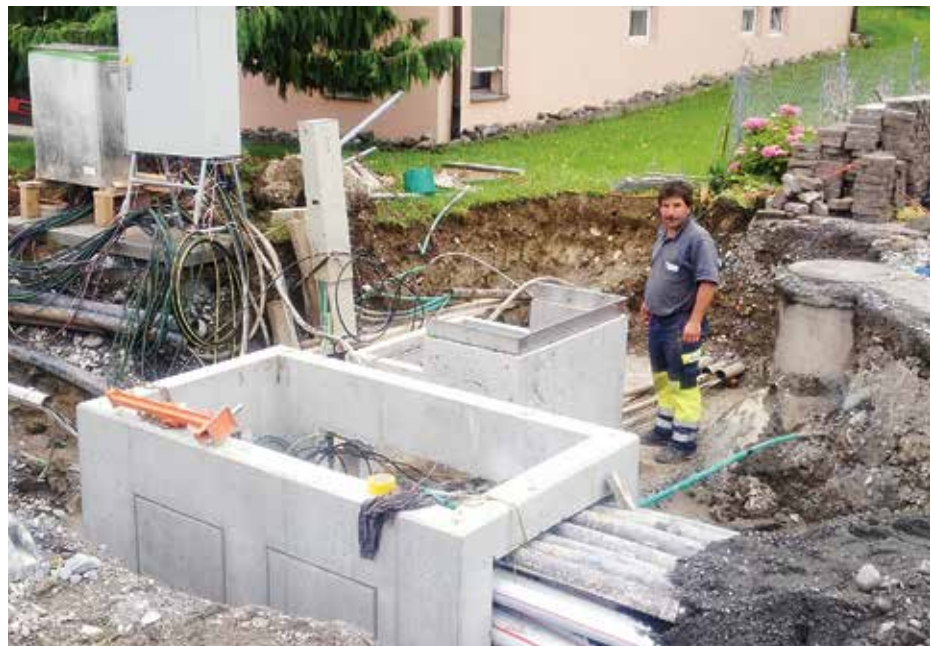
Sanierung VK Heinrich-Rosenberg-Strasse, Biltlen.
