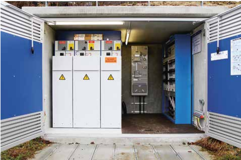
Sanierung TS Römerturm, Filzbach
