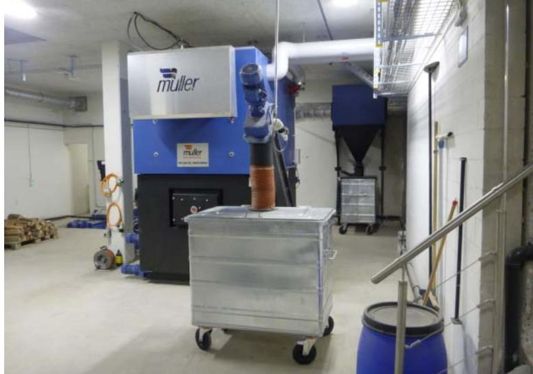
Die unterirdische Heizzentrale mit dem Schnitzelholz-Brenner
