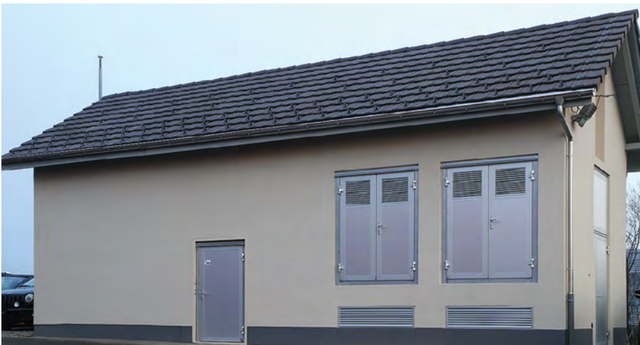
Die total sanierte Trafostation Sägestrasse in Bilten.
